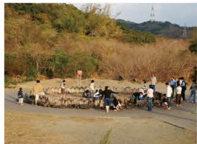
1. 墾管處接管出火後，在出火上方構築水泥柵欄。
