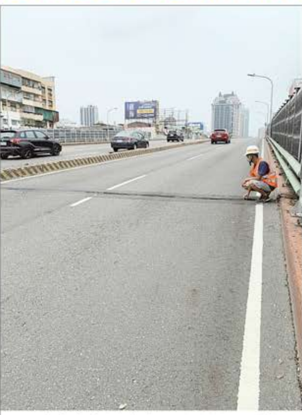
大地震後高市府連夜健檢橋梁，圖為檢測民族陸橋。(高雄市工務局養護工程處/提供)
