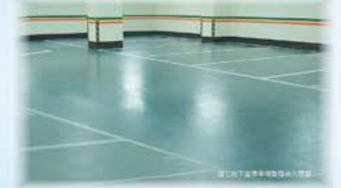
PS. 國宅第11棟地下室停車場約能停機車、機車30幾輛。光化里陳前里長任內有整頓過，卸任後長年被佔用。
