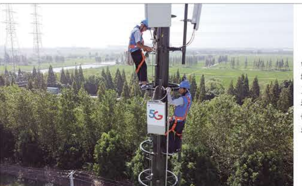
上海全面推進5G網路覆蓋，通信塔工上塔部署5G基站。
